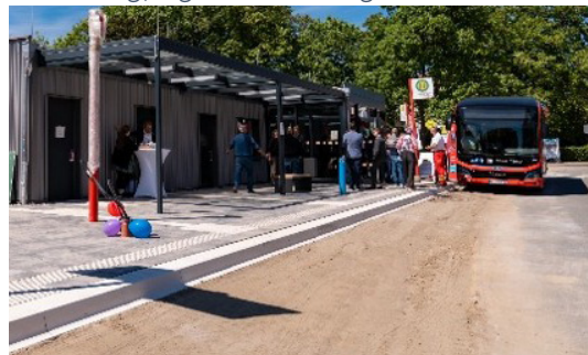
Abbildung 28: Endzustand der Plushaltestelle Lauenburg, eigene Abbildung
