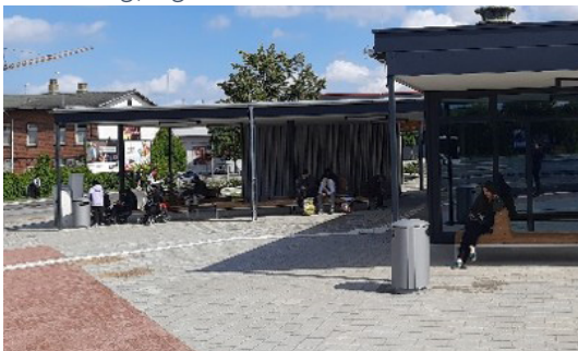
Abbildung 27: Endzustand der Plushaltestelle Lauenburg, eigene Aufnahme
