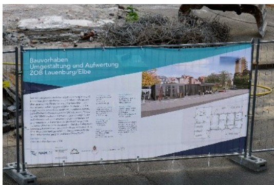
Abbildung 42: Baustellenschild Plushaltestelle-ZOB Lauenburg, eigene Aufnahme
